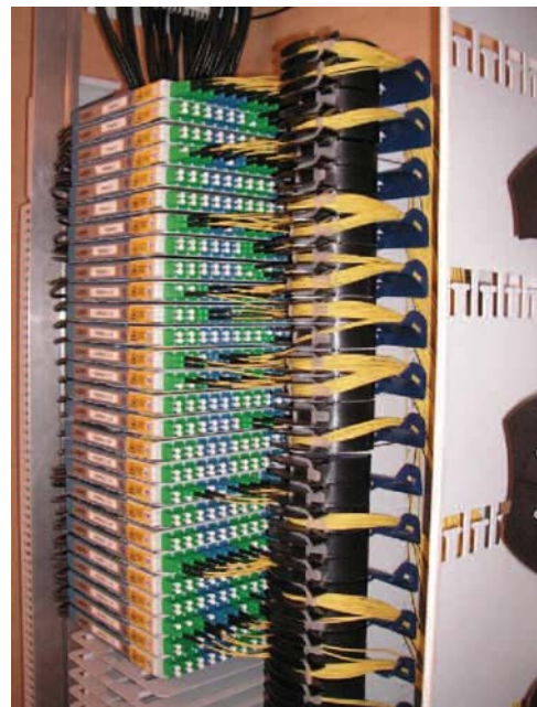
Рисунок 4. Распределительный узел для оптических линий высокой плотности (источник: Huber&Suhner)
